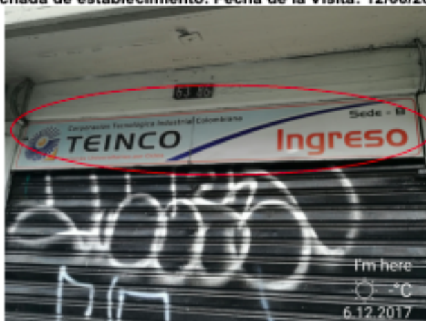
Fotografía No. 2. Sede 1. Conductas evidenciadas: Los elementos no cuentan con registro ante la SDA, Cuenta con más de un aviso por fachada (ver fotografía 1). Fecha de la Visita: 12/06/2017.
